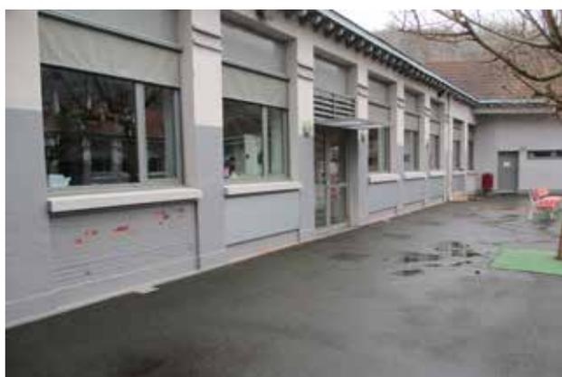
Le soubassement des fenêtres subissant les désagréments du salpêtre et nécessitant de les peindre régulièrement, le choix a été fait de poser des panneaux de « TRESPA » sur des tasseaux de bois afin de maintenir une ventilation à l'arrière.
